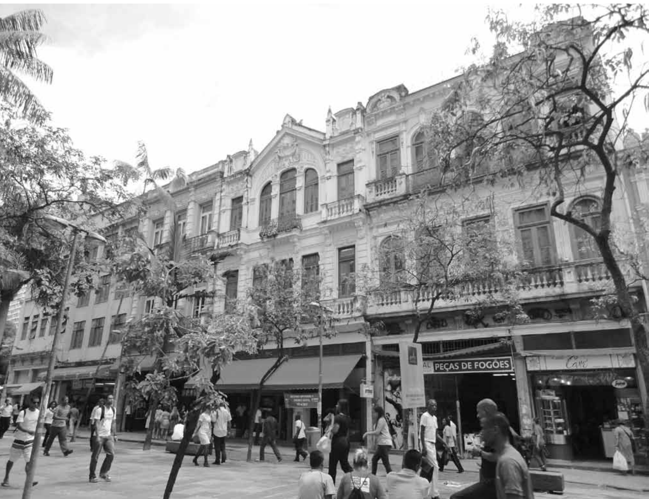
Figura 11 – Rua Uruguaiana entre o largo da Carioca e a rua Sete de Setembro, lado ímpar. Nesta quadra e na seguinte, estão localizadas as edificações mais monumentais da rua. Fonte: autora, 22/11/2011.
