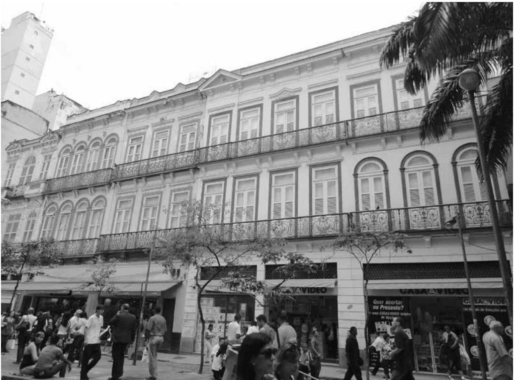
Figura 8 – Edifícios à rua Uruguaiana nº 31, 33, 35 e 37. Foto: autora, 22/11/2011.
