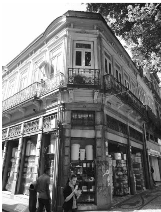
Figura 3 – Edifício à rua do Ouvidor nº 45, esquina com a Rua Primeiro de Março. Fonte: autora, 08/08/2011.
